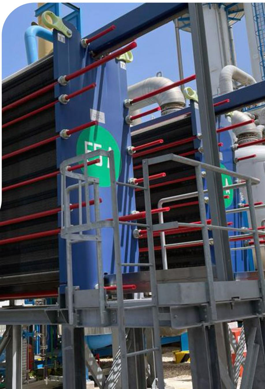
I compressori d'aria Atlas Copco vengono utilizzati per aumentare la pressione dell'aria a 6 bar. Quando viene compressa le temperature dell'aria raggiungono più di 120°C, e devono essere raffreddate. La sfida consiste nel raffreddare l'aria in due fasi, il tutto con una perdita di carico minima. Primo stadio con acqua della torre di raffreddamento ed il secondo, con acqua refrigerata, e fra ogni stadio si recupera l'acqua di condensa dell'aria umida.
